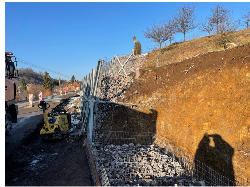
Spodný kôš gabionového oporného múrika
