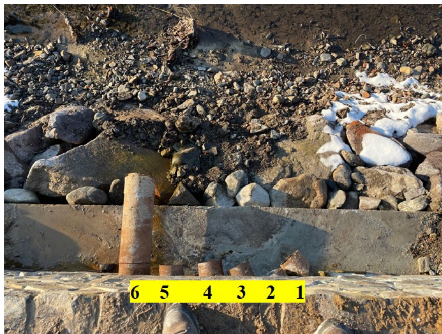
Vyústenie HOV do potoka Štiavnica
