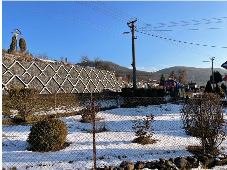
Pohľad na oporný múr – dvojstupňová oceľová kotvená konštrukcia
