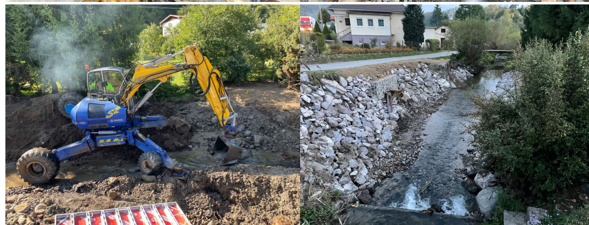
Realizácia HOV; úprava koryta Štiavnice a pohľad na sfinalizované práce spolu s výustným objektom HOV
