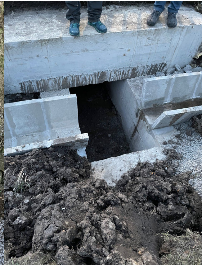
Úprava a vyčistenie výtokovej časti priepustu – vľavo a rekonštrukcia cestnej priekopy
