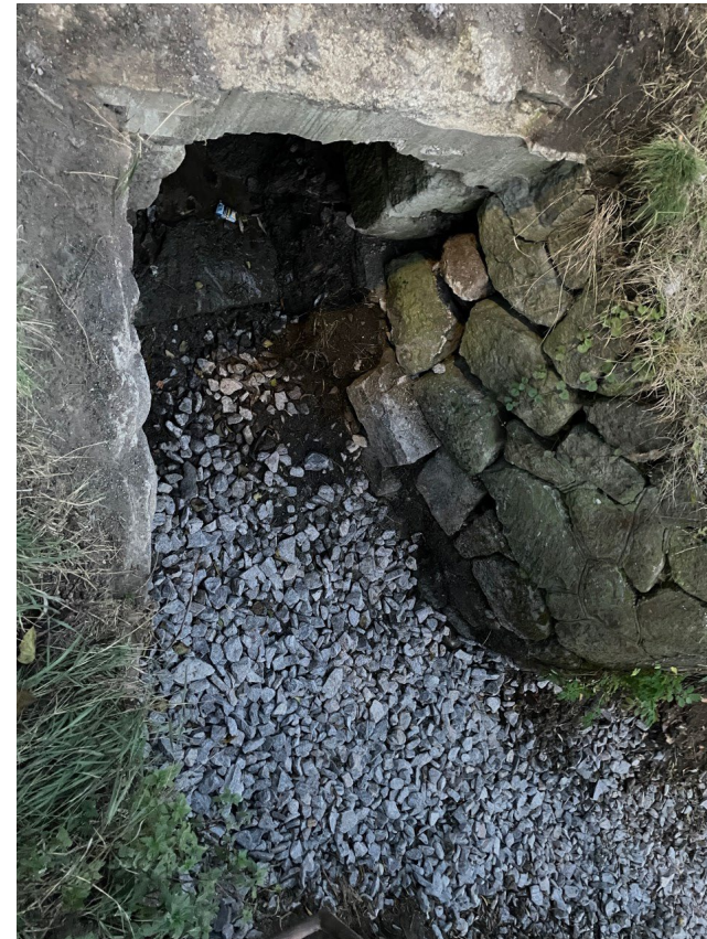
Úprava a vyčistenie výtokovej časti priepustu – vľavo a rekonštrukcia cestnej priekopy
