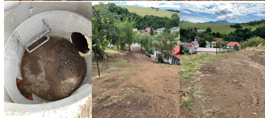
Hore – situácia nad odľučnou hranou zosuvu v priestore ihriska v marci 2020; kontrolné šachty a povrchový rigol; drenážno-stabilizačné rebrá - dole
